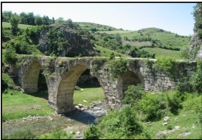
Foto 1. Restorasyon öncesi tarihi Kurtköprü'ye güneydoğudan bakış (B.Kıvrak).
